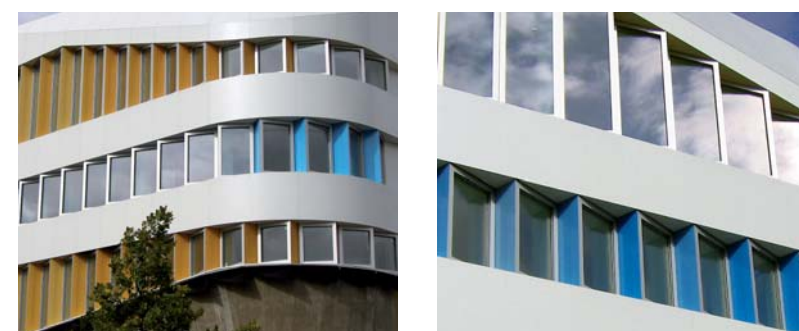
Bild oben: Das ZVE setzt sich mit dem strahlenden Weißgrau der beschichteten Alukassetten und den scharfkantigen Fenstereinschnitten von der Umgebung ab. Bilder unten: Detailsichten der Sägezahnfenster.
