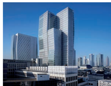
Bild oben: Das PalaisQuartier mitten in Frankfurt/Main; Bild unten: Büroturm mit Skyline im Hintergrund
