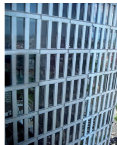
Detail der elementierten Doppelfassade
