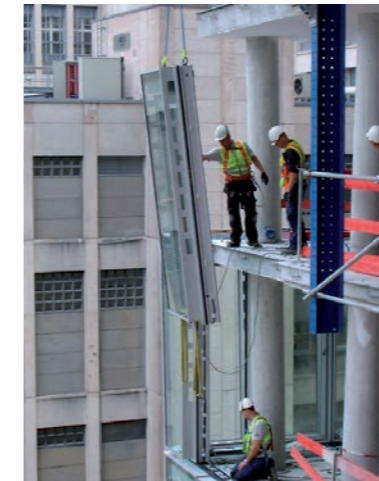
Unser Team bei der Montage der Fassadenelemente
