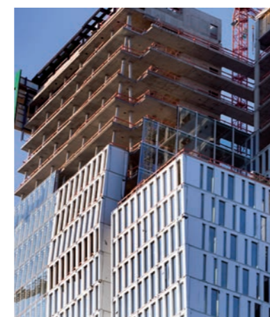
Büroturm während der Bauphase; in den letzten Zügen ...
