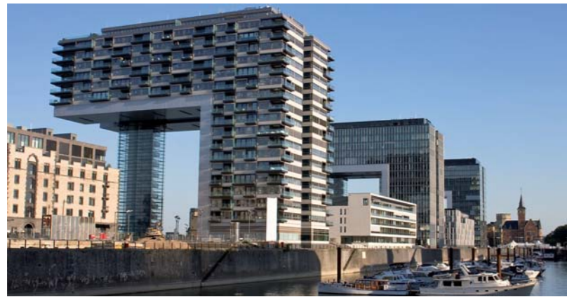
Ein Standort wie kein anderer: Das „Pandion Vista“ auf der Halbinsel des Rheinauhafens.
