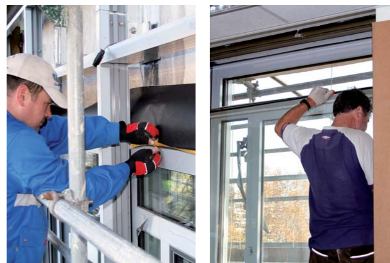
Die neuen Fensterelemente werden abgedichtet (Bild links), und die alten Fenster auf der Innenseite demontiert (Bild rechts).
