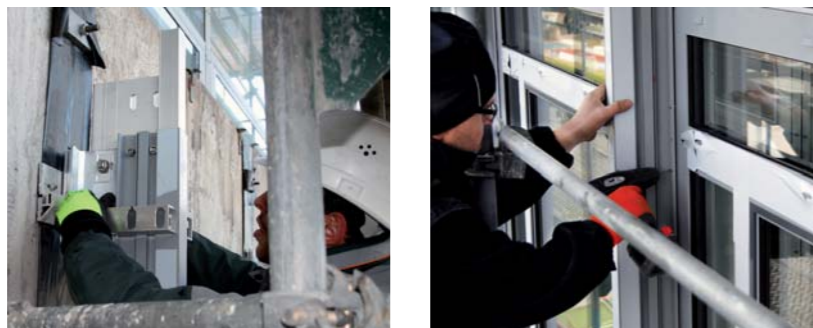
Bild oben: Wir rüsteten das Gebäude vor dem Montageprozess komplett ein. Bilder unten: Die Befestigungskonsolen werden am Baukörper befestigt; unsere Monteure bringen die neuen Fensterelemente auf den Innenseiten der Traglisenen an.
