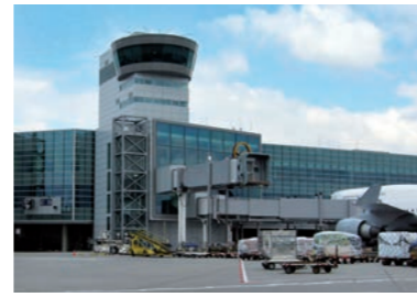
Die Fassaden des C/D-Riegels, Vorfeldansicht
