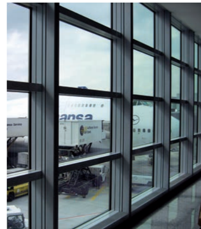
Gate-Fassade von innen
