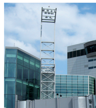
Aufzugsturm (mittig im Bild)
