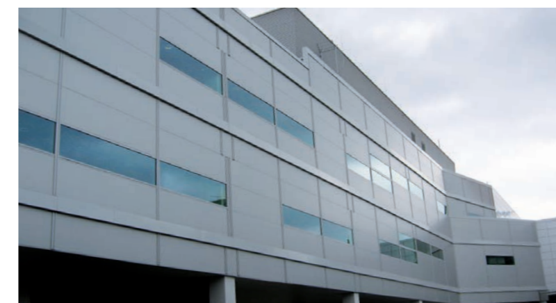
Verbindungsgang mit Brandschutzfassade
