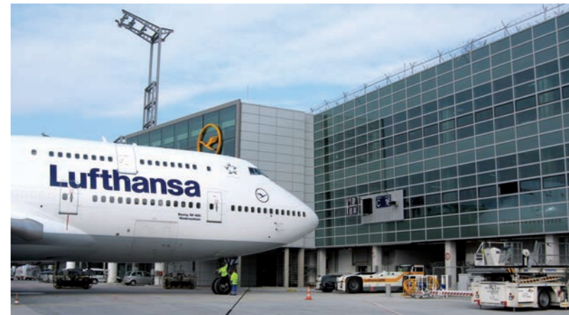
Blick von außen auf eine Gate-Fassade
